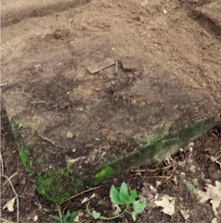
**Punkt 4**, Detail, vorne ist der abgesägte Armierungsstab sowie weitere Metallteile zu sehen, mit dem die Stahlkonstruktion an dem Fundament verankert war.
