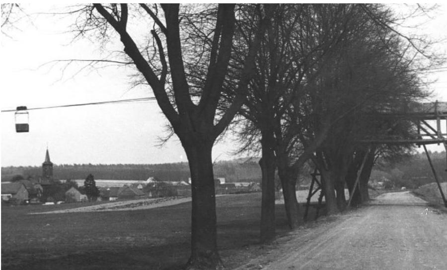
Von der Winkelstation am westlichen Ende der Seilbahn geht eine Seilbahn nach Norden zur Grube Stückfeld. Das Ende der Seilbahn ist fast schon am Rand des Ortes Bernsfeld positioniert. Gut zu erkennen ist die Schleife der Bahn für die Loren, die direkt ins Seilbahngebäude hineinführt und auf der hinteren Seite über ein Rangiergleis um das Gebäude herum wieder zurück in die Grube führt.
