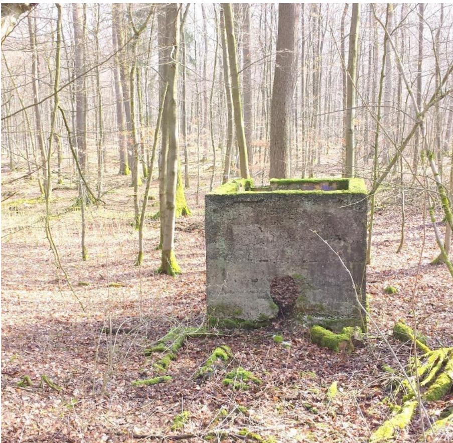
Auf diesem Foto ist das Loch zu sehen, in dem ursprünglich die Rohrleitung ansetzte. Die Blickrichtung geht genau zur Erzwäsche Albert. Auf Grund der zumindest heute sehr wassereichen Umgebung der Erzwäsche Albert ist anzunehmen, dass sie der Ableitung von Waschschlamm aus der
