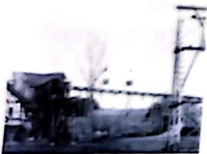
In der Aufgabestation der Grube wurden jeweils zwei leere Seilbahnkübel auf spezielle Bockwagen gesetzt, die über Feldbahngleise zu den jeweiligen Abbaustellen gefahren und dort befüllt wurden. An einem Hauptgleis zweigten zahlreiche Nebengleise ab, die es den Bergleuten ermöglichten, gleichzeitig mehrere Kübel zu füllen. Über ein weiteres Gleis liefen die Bockwagen mit den gefüllten Kübeln zurück zur Aufgabestation.
