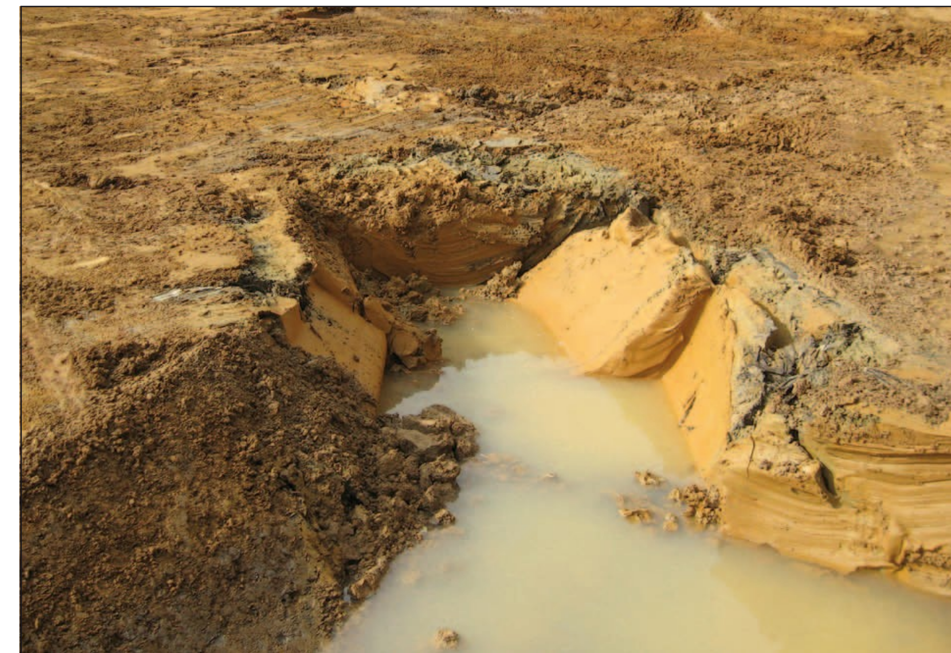
Mit Schlamm verfüllter Stollen im Bereich der Grube Ernestine alt (Foto Werner Wißner)
