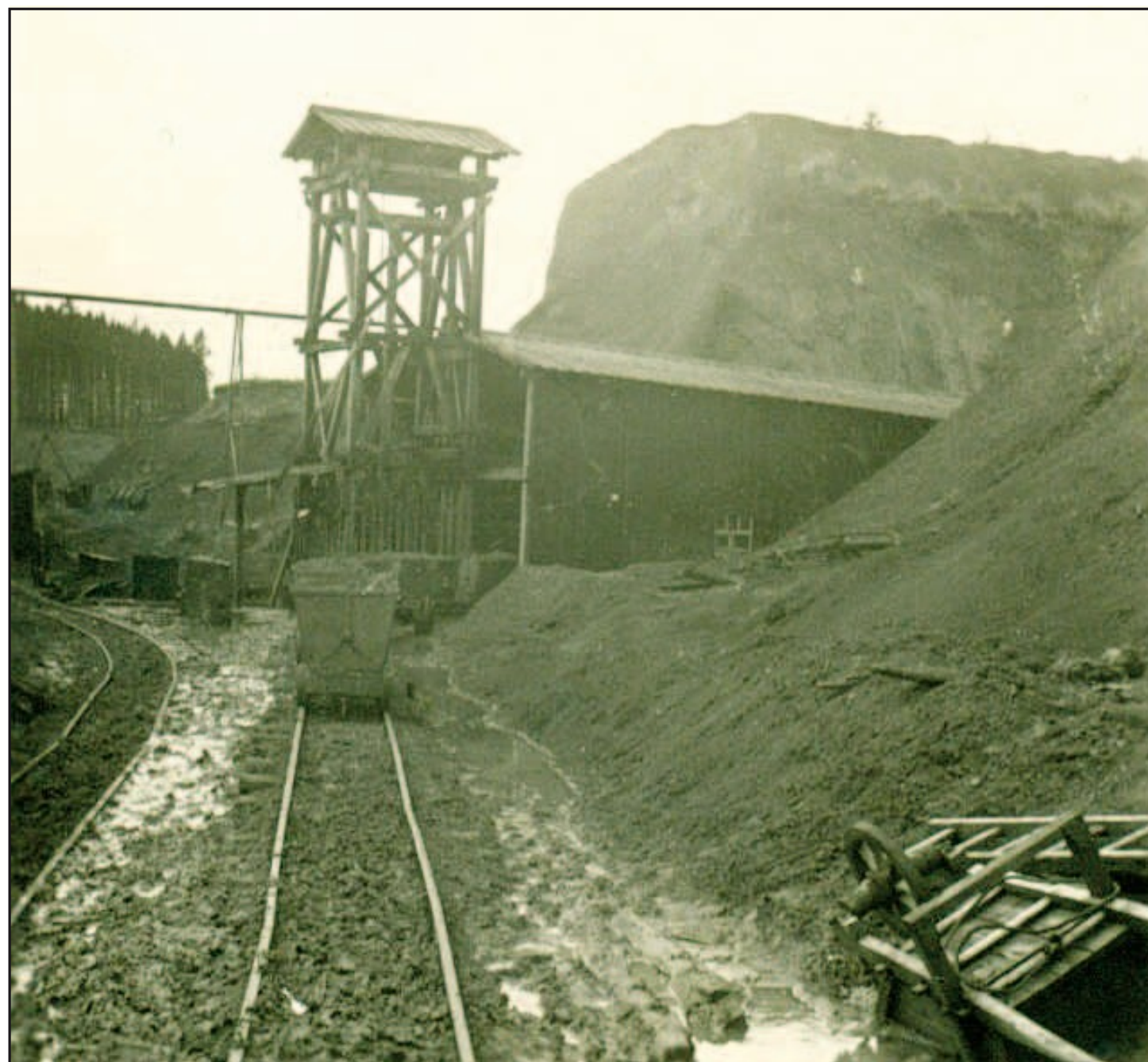
Grubenbahn mit Seilbahnaufgabe und Gerüst für die Gewichte der Seilspannung in der Grube Otto-Elisabeth (Sammlung Kurt Seim)
