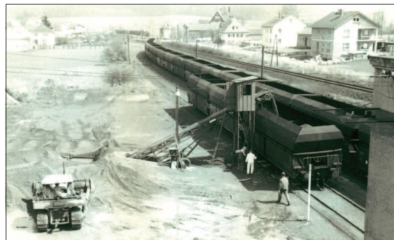
Bahnverladung von Fertigerz der Aufbereitung Eisen/Ernestine auf dem Verladegleis der stillgelegten Aufbereitung Mücke vor der Fertigstellung der Rampe am Bahnhof (Sammlung Kurt Seim)
