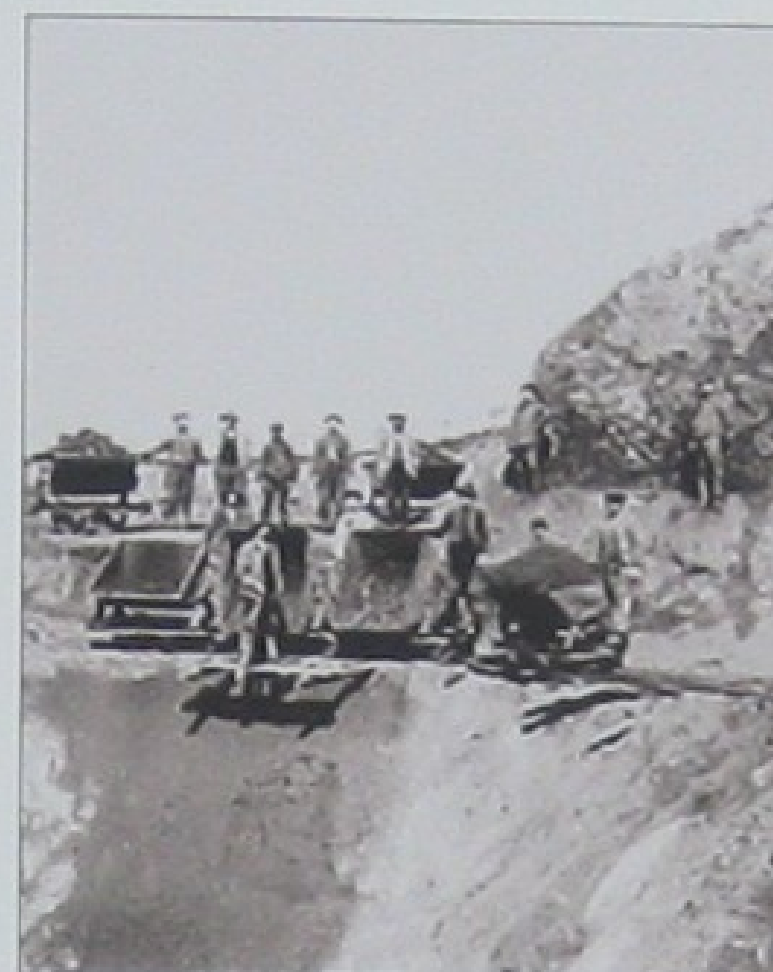
Dreimorgenfeld um 1920, Loren auf der Schmalspurbahn zur Erzwäsche. (Quelle: Bildausschnitt aus Georg. Haus, Porezag, Eisenerzbergbau in Hessen, 1986)
