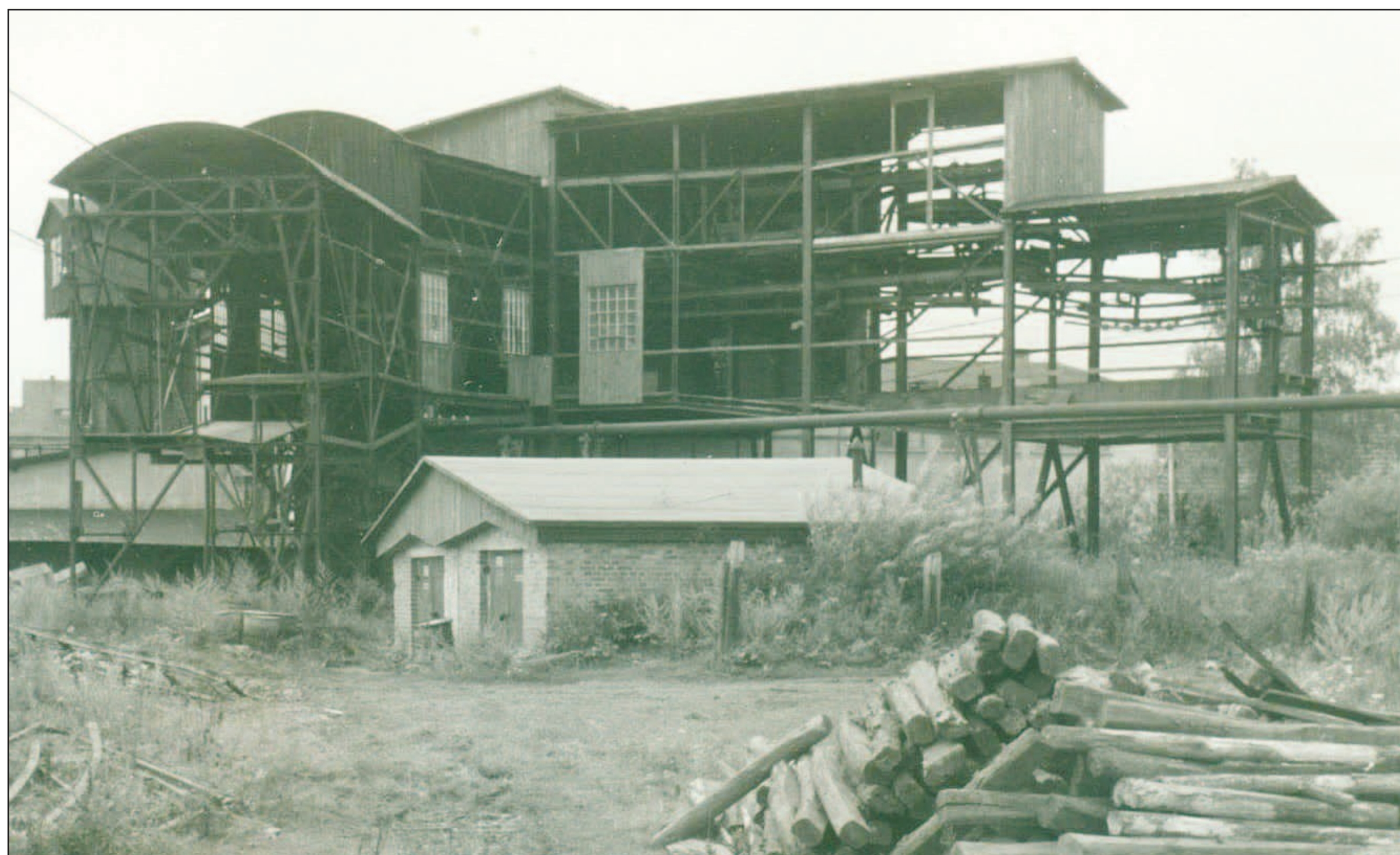
Seilbahneinläufe der Aufbereitung Mücke, links aus Grube Eisen, rechts aus Grube Otto-Elisabeth (Sammlung Roland Becker)
