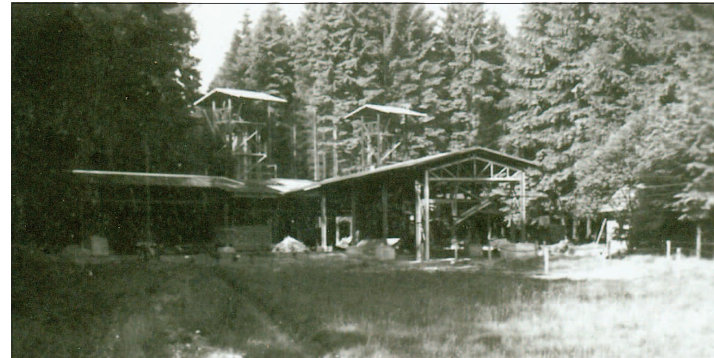
Winkelstation westlich der Grube Otto-Elisabeth mit Ein- und Ausläufen und Gerüsten für die Gewichte der Seilspannung (Sammlung Kurt Seim)
